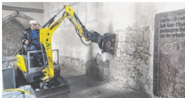
Der Innenputz wird abgeschlagen und der Boden wird erneuert.
