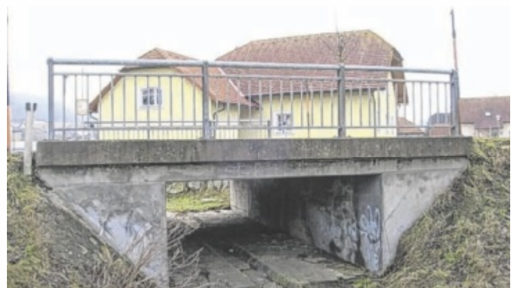
Der bestehende Hochwasserdurchlass hat ausgedient. Foto: Land OÖ
