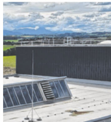
Shed Verglasung inkl. RWA-/ Lüftungsja-lousien, Absturzsicherung, Lichtkuppel
