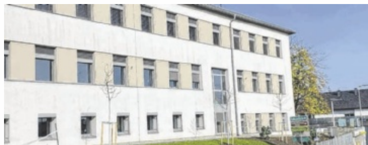
Die groß angelegte Sanierung der Neuen Mittelschule konnte erfolgreich abgeschlossen werden.
