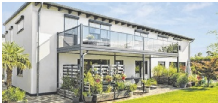
Ein nachträglich installierter Balkon von Leeb
