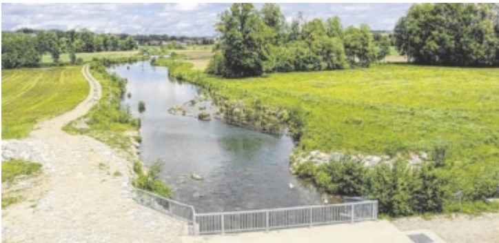
Das Rückhaltebecken Krems-Au erhielt den Adaptterra Award.
