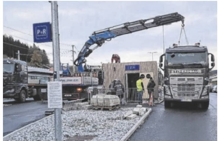
Die Außenwand der Sanitäranlage wurde errichtet. Foto: Marktgemeinde Kremsmünster
