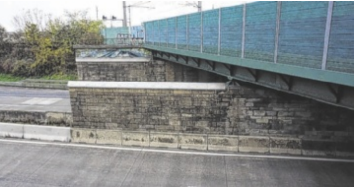
Die bestehenden Pfeiler können für die Radbrücke verwendet werden. Foto: mott
