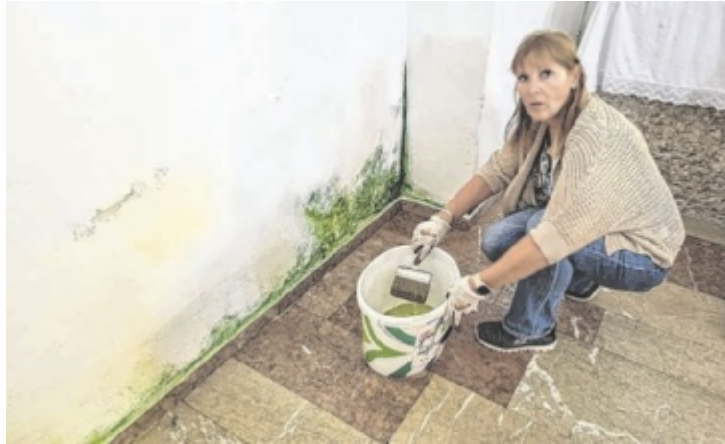
Obfrau Leopoldine Berger beseitigt den Schimmel an der Kirchenmauer. Fotos: privat
