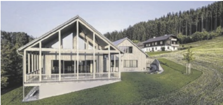
Die Fassade des Kundenzentrums besteht aus sägerauem Fichtenholz. 270 Kubikmeter Holz wurden insgesamt verbaut.
