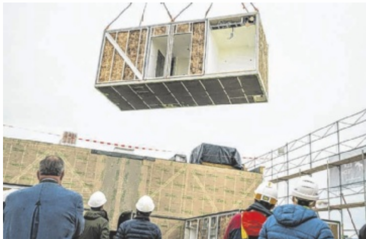
Die fertigen Module werden per Kran eingehoben.
