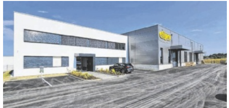
Nach neun Monaten Bauzeit war der Neubau fertig.
