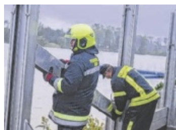
Aufbau des Hochwasserschutzes, Mauthausen Foto: FOTOKERSCHI / KERSCHBAUMMAYR
