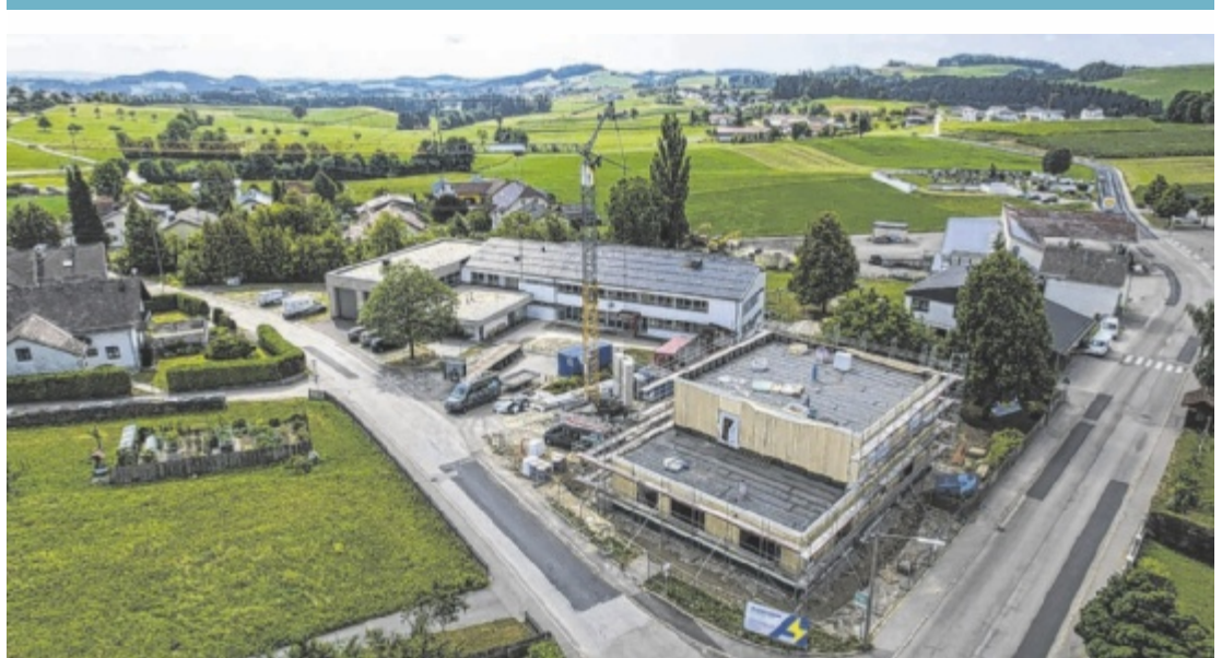
Auf der Baustelle beim Kindergarten-Neubau ist schon viel geschehen.
