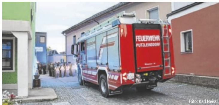
Die enge Zufahrt zum Feuerwehrhaus ist ein Grund für den geplanten Neubau. Foto: Karl Neissl
