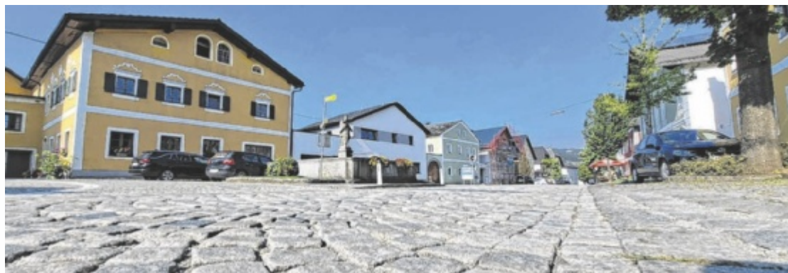
Die Fahrbahn im Ortszentrum von Putzleinsdorf besteht aus Pflastersteinen. Sie sind vielen ein Dorn im Auge. Foto: Hanner
