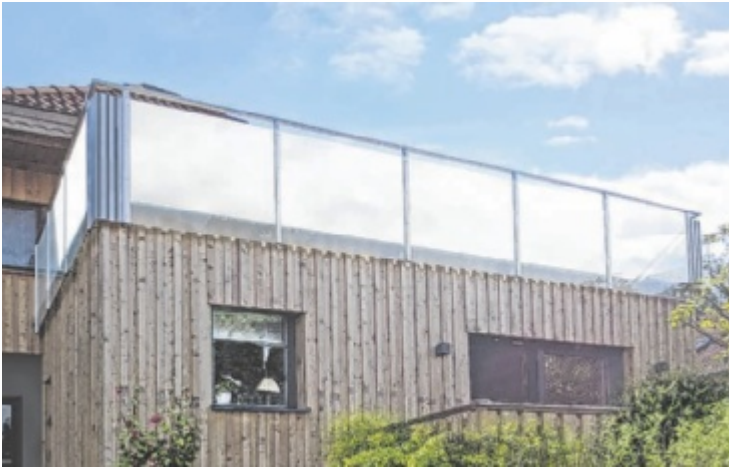
Links: Edelstahl-Glasgeländer, rechts Anbaubalkon aus Edelstahl mit Holzboden.
