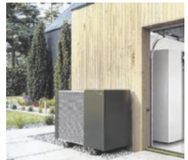
Eine Wärmepumpe kann eine Alternative zur alten Öl- oder Gasheizung sein – auch beim Sanieren. Foto: Austria Email
