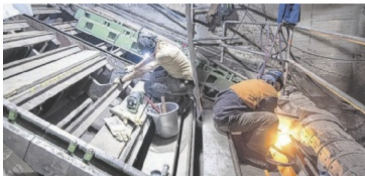
Erneuerung des gesamten Rostes in der Brennkammer
