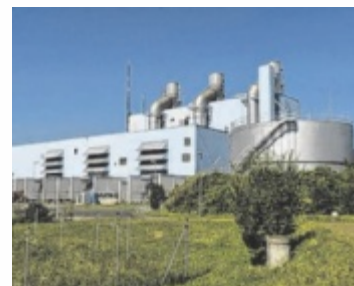
Das Fernheizkraftwerk Linz-Süd der LINZ AG
