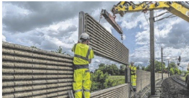
Installation der neuen Schallschutzwand aus Recycling-Beton Foto: Kirchdorfer Group/Postl
