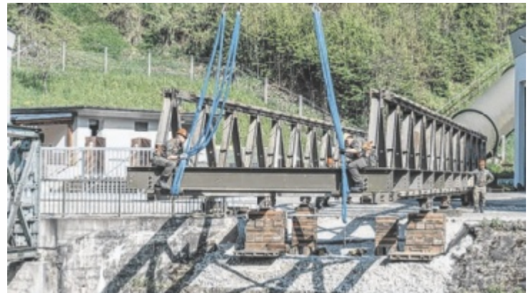
Bundesheer-Soldaten bei der Montage einer Behelfsbrücke beim Kraftwerk Partenstein Foto: BMLV / Klaus Unterbuchberger
