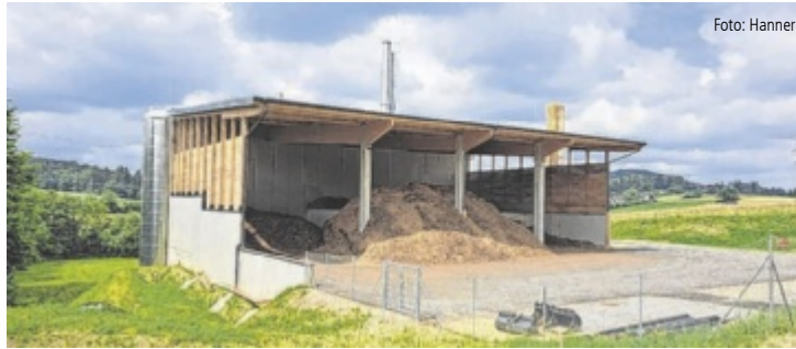
Erst zum Teil fertig: das neue Hackschnitzelheizwerk in der Bezirkshauptstadt
