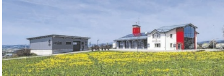
Das Feuerwehrhaus mit dem neu errichteten KHD-Lager
