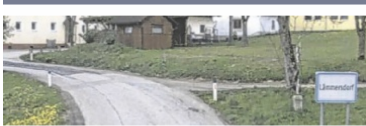
Die Arbeiten an der Hanrieder Straße bei Lämmersdorf laufen.
