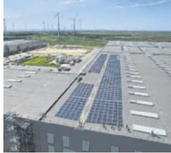
Photovoltaik-Anlage am XXXLutz Zentrallager.
