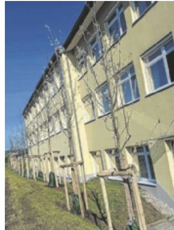
Die Pappeln wurden auf der Südseite des Gebäudes gesetzt.
