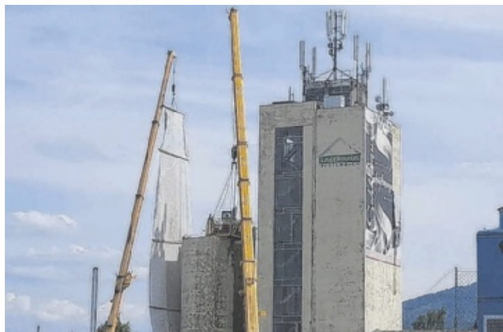
Die Silos im Ortszentrum wurden bereits abgerissen.
