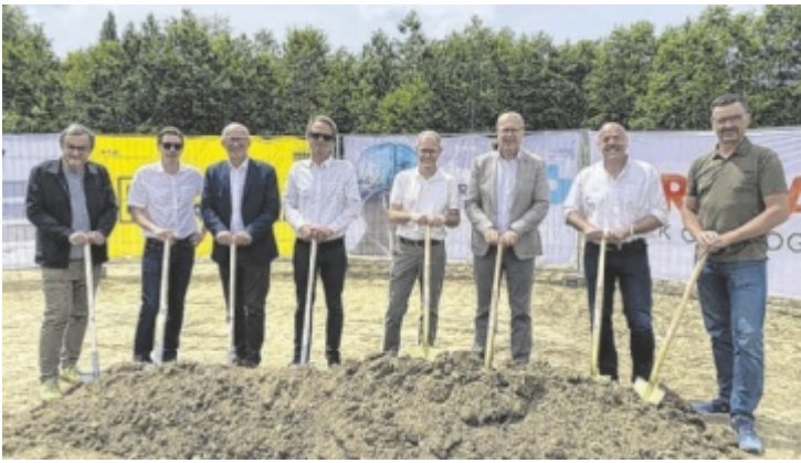
Die Gesellschafter haben den Spatenstich für das neue Nahwärme-Heizwerk Velden gesetzt.
