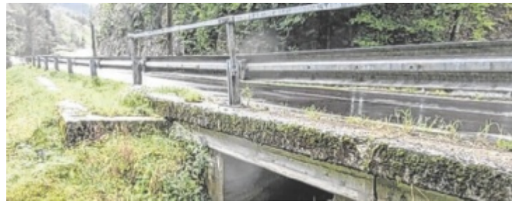
Die Bauarbeiten dauern voraussichtlich bis Mitte September.
