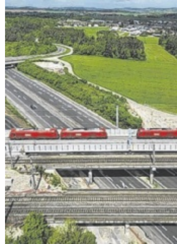
Testfahrt über die Brücke
