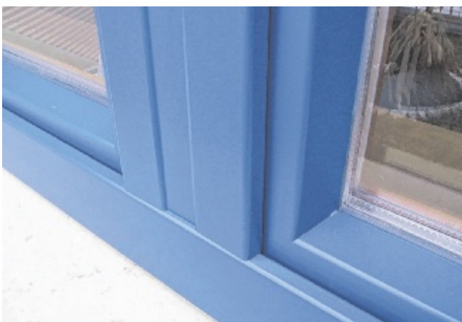
Saniertes Fenster mit Aluminiumverkleidung
