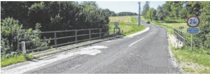
Die Kothmühlbrücke auf der Thann Straße wird neu gebaut.
