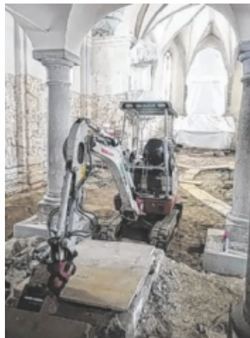
Die Bauarbeiten laufen. Fotos: Pfarre Kleinzell
