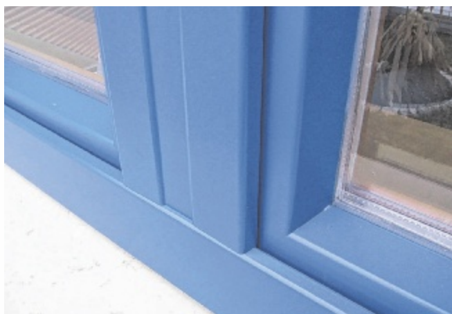
Saniertes Fenster mit Aluminiumverkleidung
