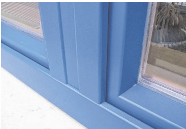
Saniertes Fenster mit Aluminiumverkleidung
