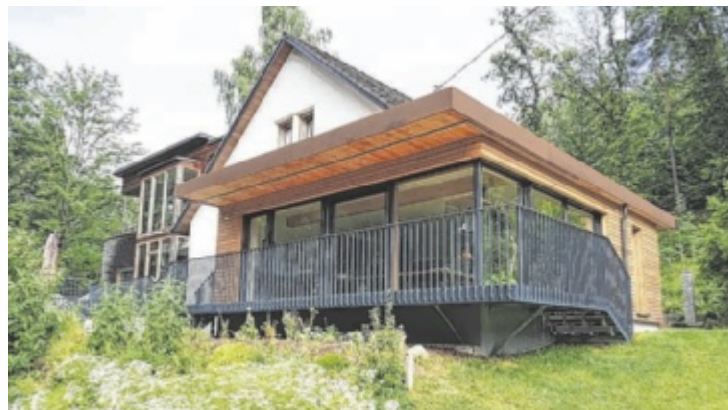
Sanierung Einfamilienhaus 2019 (Baujahr 1976)
