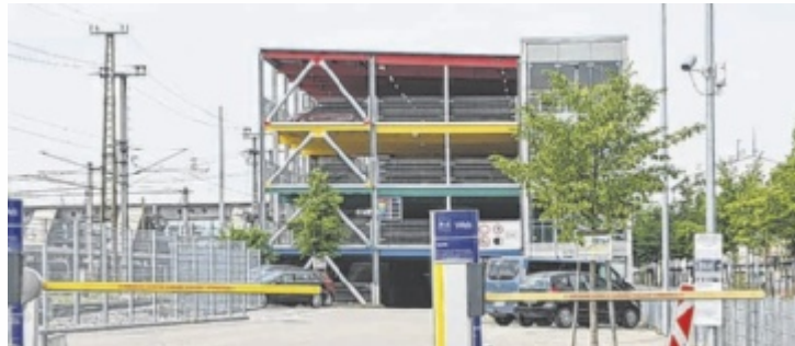
Das Parkdeck am Welser Bahnhof wurde 2018 eröffnet.
