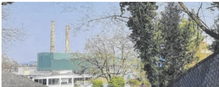
Der 106 Jahre alte Schlot, auf dem Bild links, wird abgetragen.
