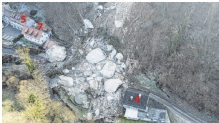
Die Häuser Rosenegger Straße 4 und 7 müssen wahrscheinlich abgerissen werden. Das Schicksal von Hausnummer 5 ist noch offen.
