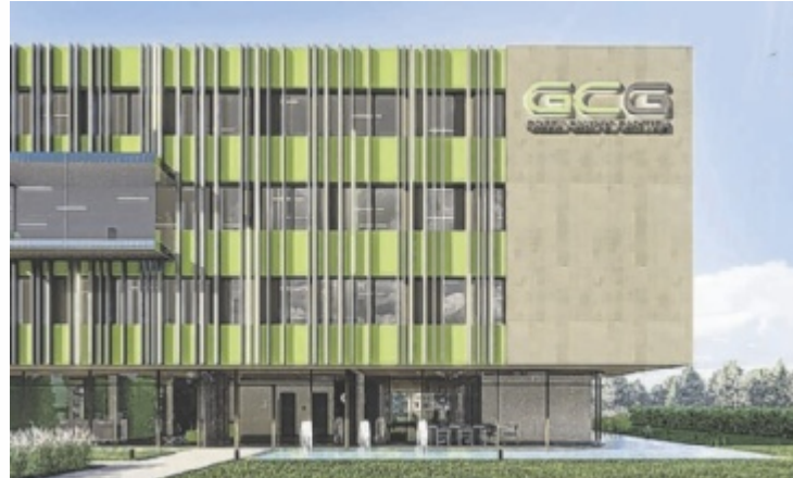
Im Laufe der kommenden drei Jahre entsteht der „Green Campus Garsten“. Der Baustart ist für den Sommer geplant.
