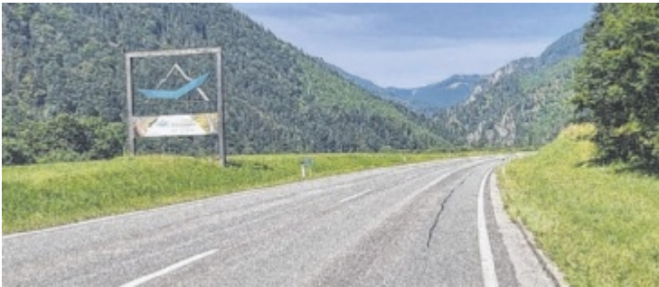
Neben der Bundesstraße zwischen Altenmarkt und Kleinreifling soll ein Fahrradweg gebaut werden. Foto: rh
