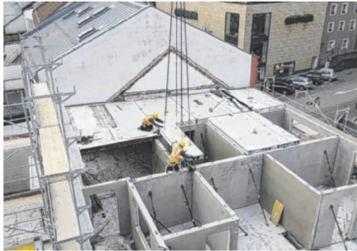
Betonfertigdecken bieten sich auch im Objektbau an.
