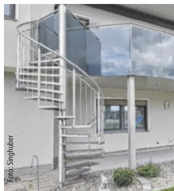
Wendeltreppe – eine platzsparende Lösung, um in den Garten zu gelangen
