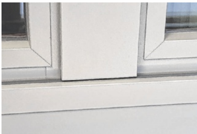
Saniertes Fenster mit KANOVA Aluminiumverkleidung
