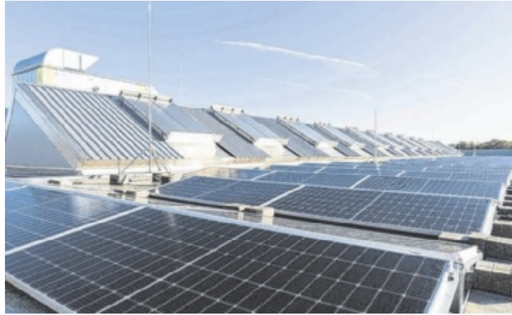
Neue PV-Anlage auf den Dächern der Stiya-Produktionsgebäude Foto: Stiya Group
