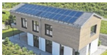
Plusenergiehaus mit dachintegrierter Photovoltaikanlage Foto: GENBÖCK HAUS
