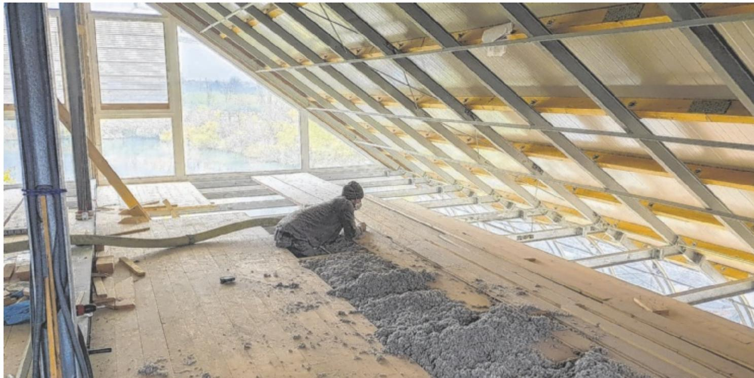
Bei Holzbauteilen, die sich verziehen können, passt sich die Dämmschicht den Veränderungen an und verhindert Wärmebrücken.
